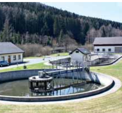
Blick auf das Nachklärbecken der Kläranlage in Klingenthal
