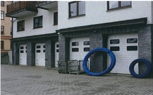
Hoffläche vor Lager und Garagen
